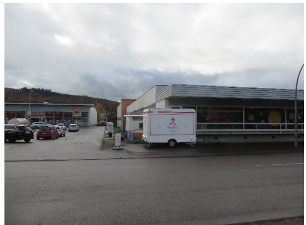
Foto 6: Gewerbe- und Einzelhandelsgebäude im Plangebiet
