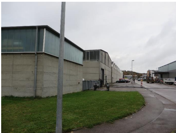
Foto 5: Industriegebäude entlang der Adolf-Kölping-Straße
